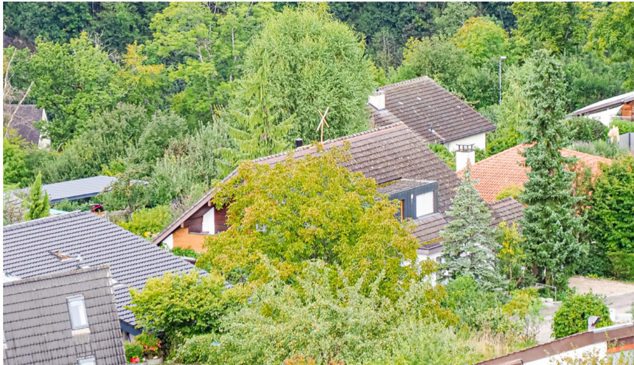
Auf seinem Haus will Peter Zbinden das erste Kleinwindrad in Hölstein errichten – das Profil steht schon. Bild hir.
